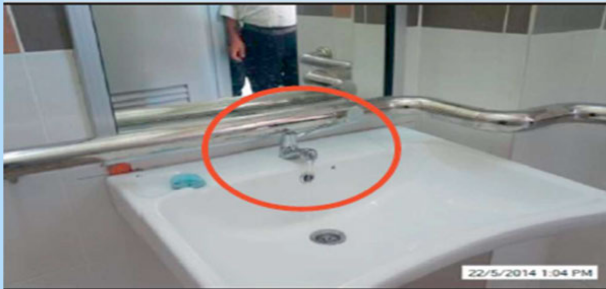
Tandas Orang Kurang Upaya (OKU) - Bar Yang Dipasang Menghalang Pili Air (22.05.2014)
