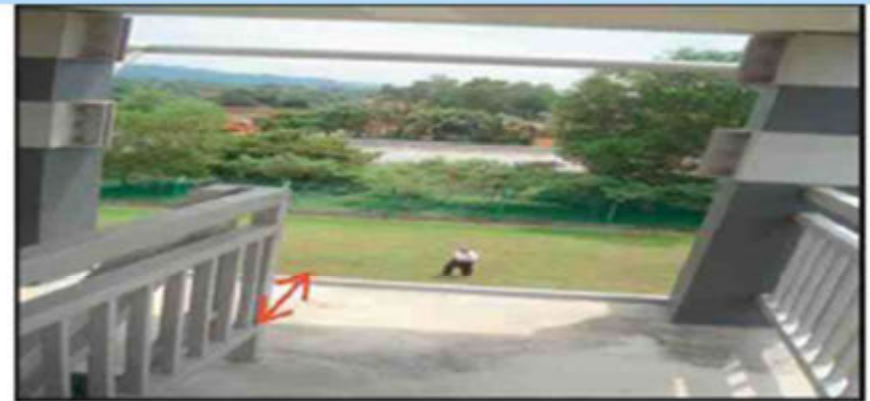
Pusat Sukan - Tiada Penghadang Mulai Dari Tingkat 3 Bagi Menjamin Keselamatan Pengguna (15.10.2014)
