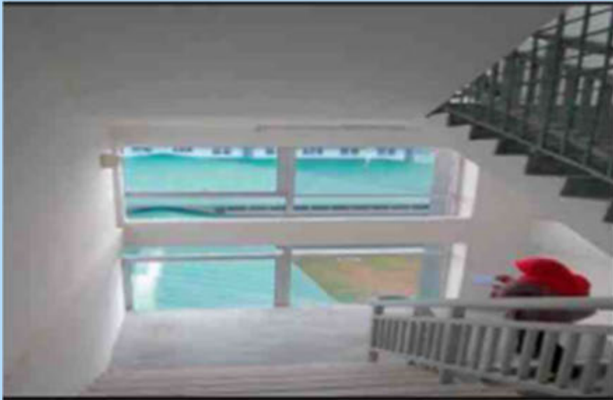
Markas PLP - Pemasangan Tingkap Cermin Di Laluan Tangga Yang Kurang Sesuai (15.10.2014)
