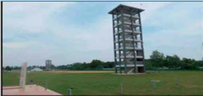
Pusat Sukan - Suspension Bridge & Flying Fox Tidak Dipasang (15.10.2014)
